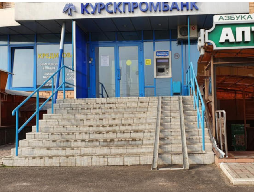
❌ Аппарели (рельсы) не могут выступать заменой пандусу. Не рекомендуется использовать для отделки ступеней тротуарную плитку
