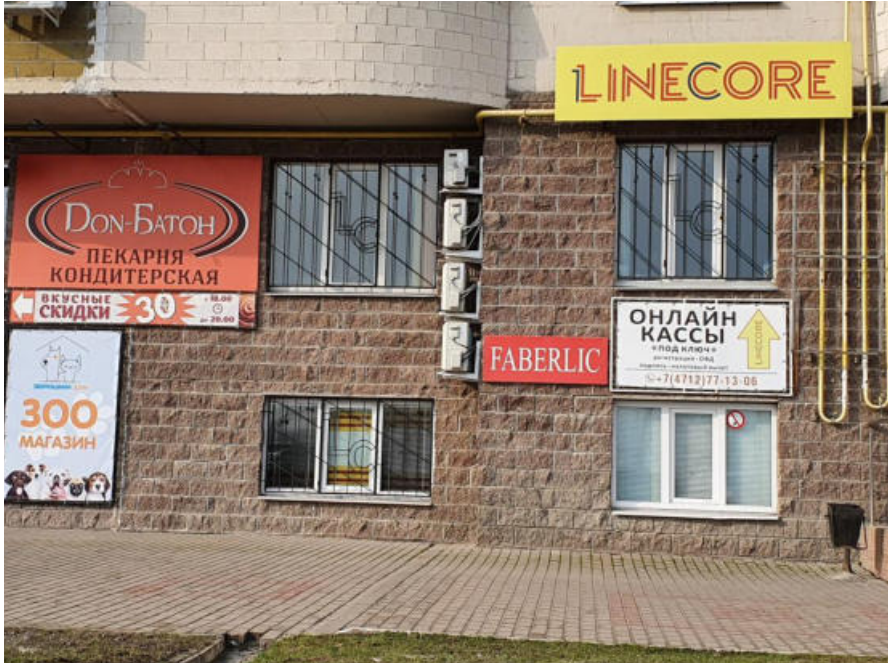
✅ Кондиционеры выведены в один ряд ❌ Кондиционеры следует скрыть за специальным экраном
