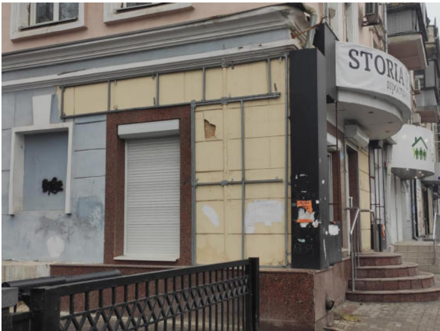
«Кусочная» облицовка фасадов приводит к тому, что после снятия отделочных материалов стена выглядит неухоженной, заброшенной и теряет свою цельность
