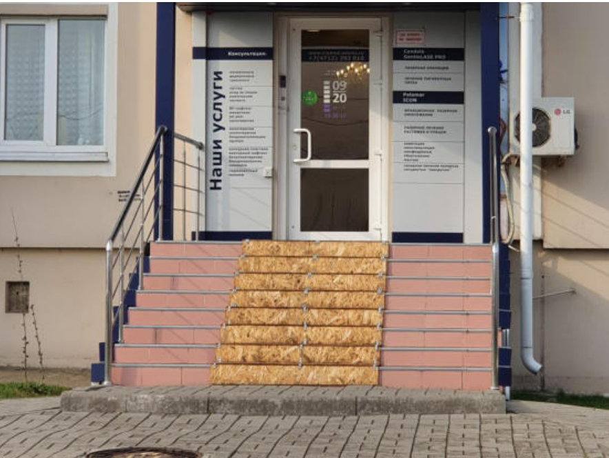
❌ Вход не имеет ни пандуса, ни автоматического подъемного устройства, ни кнопки вызова помощи для МГН. Отделка ступеней ОСБ является недопустимой и неэстетичной
