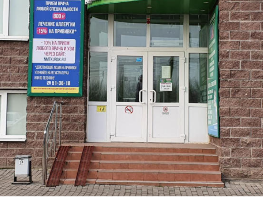
❌ Аппарели (рельсы) не могут выступать заменой пандусу. Кнопка помощи находится на верхней площадке — в недоступном месте
