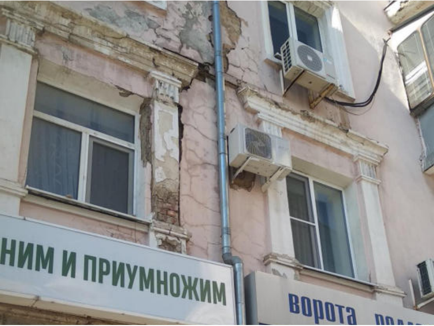
❌ Случайное размещение кондиционеров, вынесенные на фасад открытые коммуникации, аварийное состояние фасада и хаотичная реклама создают эффект «разбитых окон»
