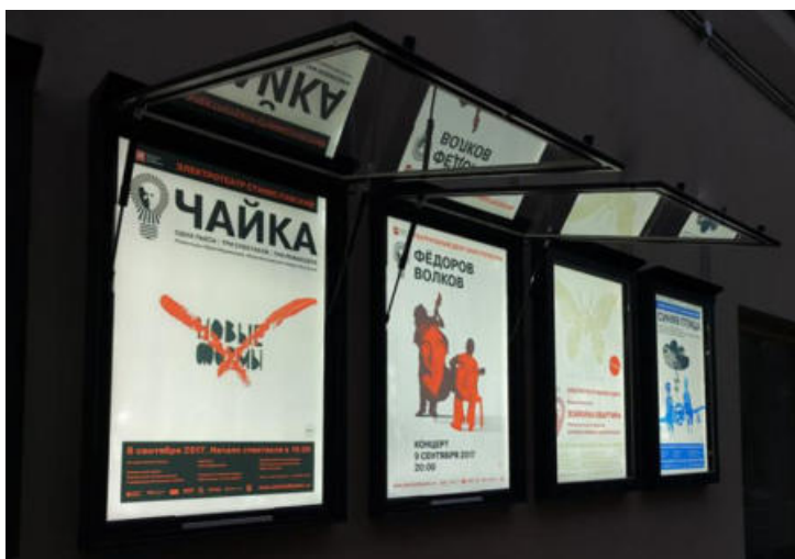
✅ Рекомендованным типом настенной конструкции для размещения афиш является световой короб из алюминия с порошковой окраской глубиной не более 90 мм с дверцей из закаленного стекла
