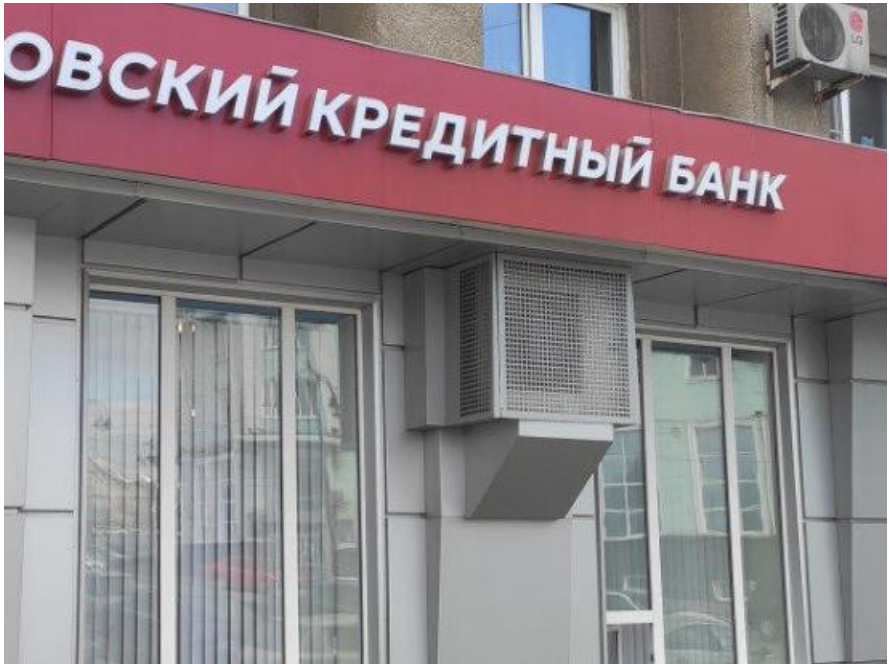
✅ Кондиционер спрятан за специальным экраном и не портит фасад здания
